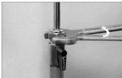
Vor der Montage von BROEN PIPEFIX® ist das Kupferrohr zu entgraten. Um ein Mitdrehen zu verhindern, ist das Kupferrohr zu fixieren. BROEN PIPEFIX® wird gespannt, bis ein starker Widerstand feststellbar ist, dann noch eine Vierteldrehung bis eine halbe Drehung weiter anziehen.
