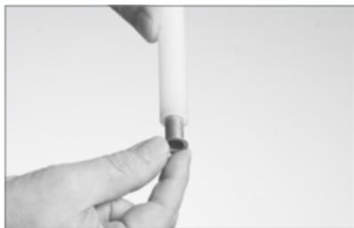
Stellen Sie sicher, dass Sie eine Stützhülse mit dem richtigen Maß in das Rohr eingesetzt haben.
