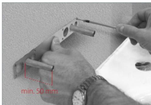
Mit der Befestigungsschablone sichern Sie bei wandmontierten Mischbatterien den Abstand zur Mitte sowie die Höhe. Sie eignet sich für Kupferrohre mit den Maßen 12 und 15 mm.
