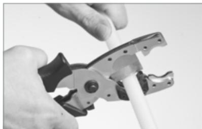
1. Schneiden Sie das Kupferrohr korrekt mithilfe eines Rohrschneiders. PEX-Rohre sind mit einer Rohrschere zu schneiden. Bei Verwendung einer Eissäge ist ein fein gezahntes Modell zu verwenden.
