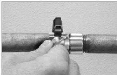
1. Kugelhahn absperren.
