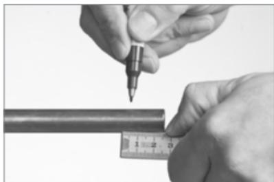
Um eine gute und sichere Verbindung zu erreichen, ist die erforderliche Einstecktiefe (siehe Tabelle 2) auf dem Rohr zu markieren. Ein zuverlässiges Verpressen mit den entsprechenden Zugfestigkeiten kann nur erreicht werden, wenn die einzelnen Elemente korrekt montiert sind. Die korrekte Verpressung ist entscheidend für die Zugfestigkeit.
