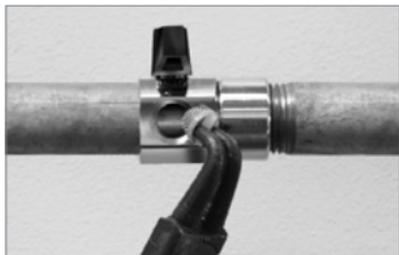
3. Filter mit einer Zange entnehmen, anschließend reinigen oder austauschen.
